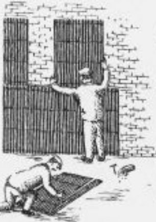
Montage der „Absorbil“-Platten
