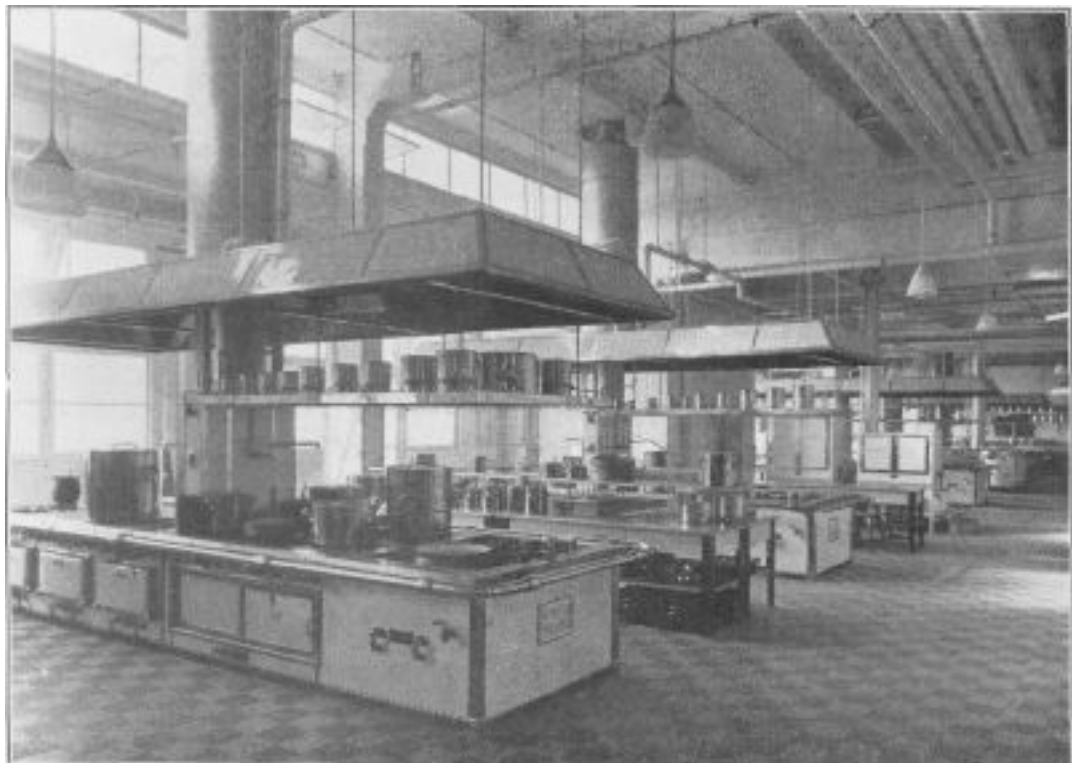
Bild 49. Zentralküche P*»*- w. Kreffl A.-a.
